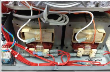
Variante 2.000W e2s: Zwei nebeneinander montierte Hochspannungstransformatoren.
